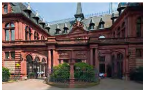
Seit Februar vergangenen Jahres residiert der Frankfurter PresseClub im Westend der Stadt in der Ulmenstrasse / Ecke Kettenhofweg. Das Livingston'sche Pferdepalais, im Volksmund „Pferdestall“, wurde von April 2011 bis Februar 2012 saniert und beherbergt neben dem PresseClub das Restaurant „Herr Franz“.
